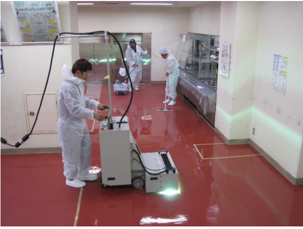
食堂床長尺シートにUVコート施工
