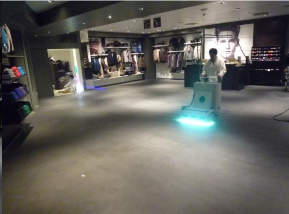
店舗コンクリート床にUVコート施工
