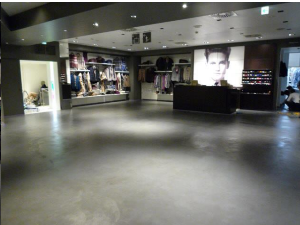
店舗コンクリート床にUVコート施工
