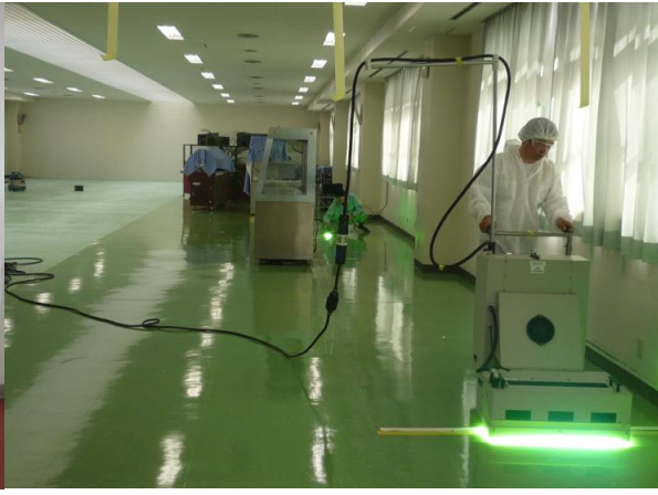
多目的ホールPタイルにUVコート施工
