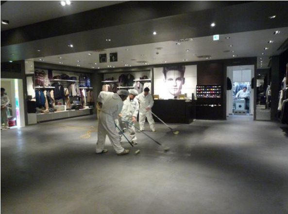
店舗コンクリート床にUVコート施工
