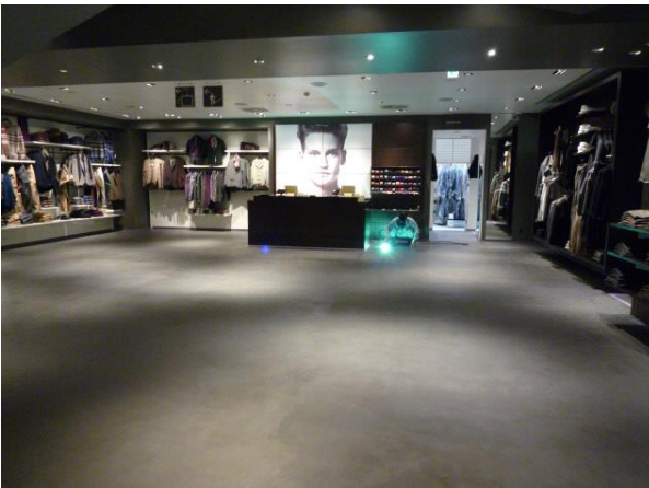
店舗コンクリート床にUVコート施工
