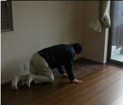
◆◆足付(下地処理) → → → UV樹脂塗料 塗布 → → → UV照射(3秒で硬化)◆◆
