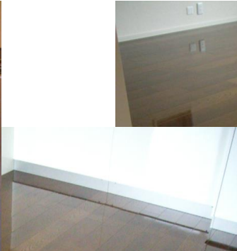
◆◆足付(下地処理) → → → UV樹脂塗料 塗布 → → → UV照射(3秒で硬化)◆◆
