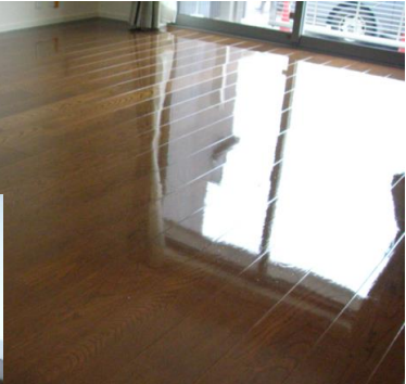
◆◆足付(下地処理) → → → UV樹脂塗料 塗布 → → → UV照射(3秒で硬化)◆◆
