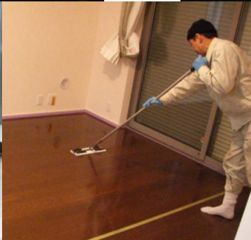
◆◆足付(下地処理) → → → UV樹脂塗料 塗布 → → → UV照射(3秒で硬化)◆◆
