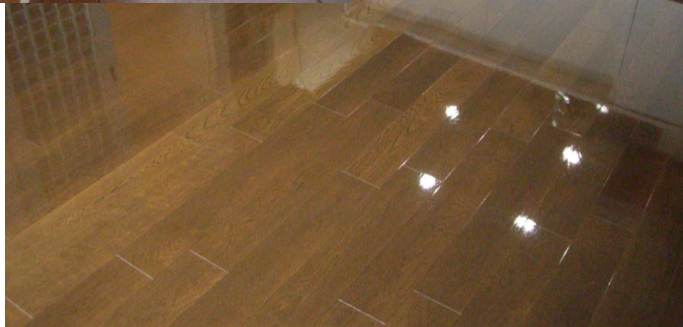
◆◆リビング 作業通路を確保 の為 半分施工 ~ 完成◆◆
