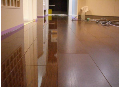
◆◆足付(下地処理) → → → UV樹脂塗料 塗布 → → → UV照射(3秒で硬化)◆◆
