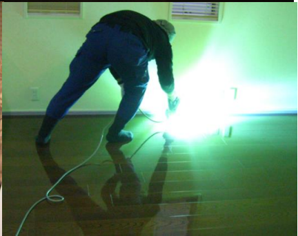
◆◆足付(下地処理) → → → UV樹脂塗料 塗布 → → → UV照射(3秒で硬化)◆◆
