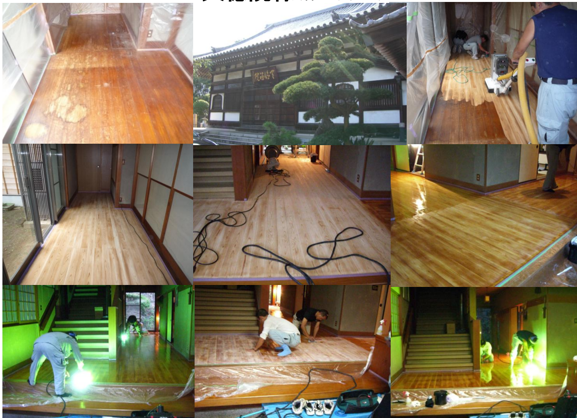
◆◆◆客殿廊下 雨染や日焼による劣化の復元工事 研磨～目止め×3工程(写真上)◆◆◆
