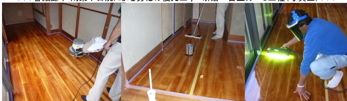
◆◆◆吸い込みの多い部分を再コーティング(写真上) 作業完了(写真右・下)◆◆◆
