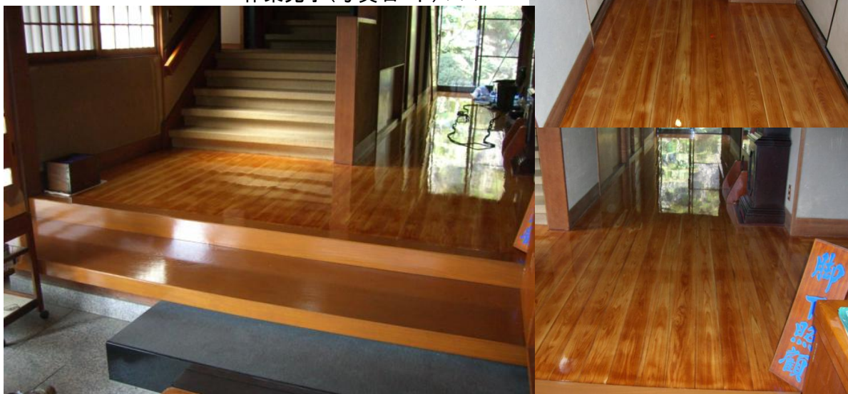
◆◆◆吸い込みの多い部分を再コーティング(写真上) 作業完了(写真右・下)◆◆◆
