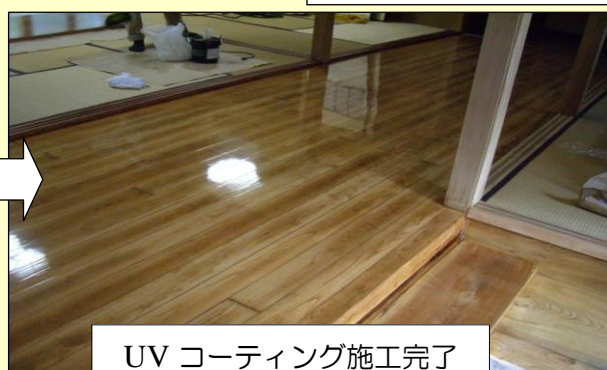
コーティング剤塗布後 紫外線照射作業
