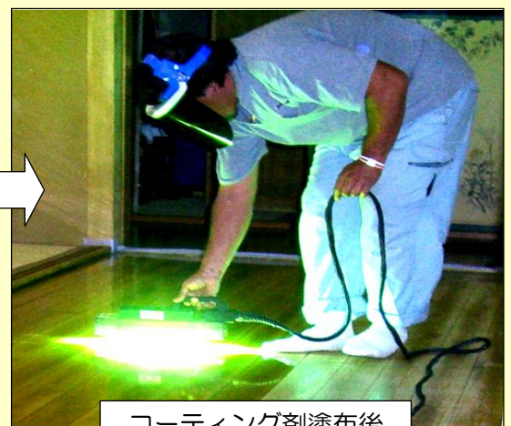
コーティング剤塗布後 紫外線照射作業
